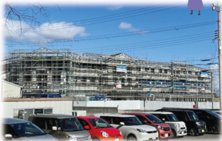
病院職員駐車場から県道を挟んだ建設工事の様子 (2月撮影)
