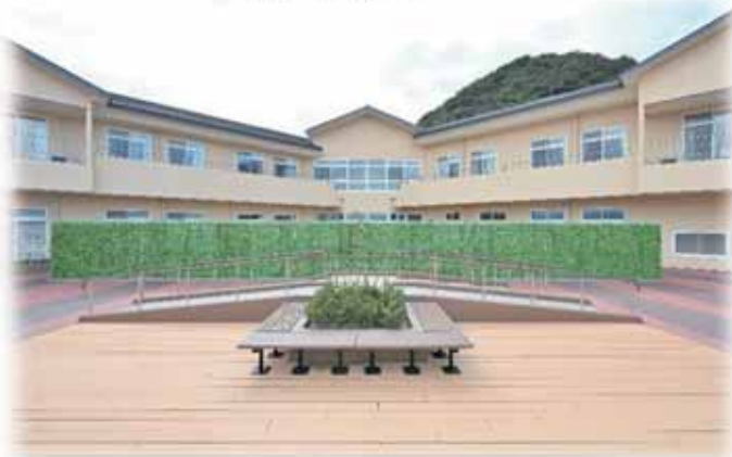
2階の屋上庭園
